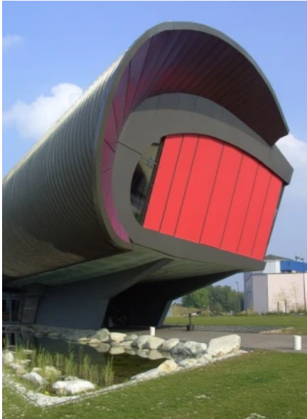
Brichta Gegenzuganlage, Verwaltung der Müllverbrennung Schwandorf
