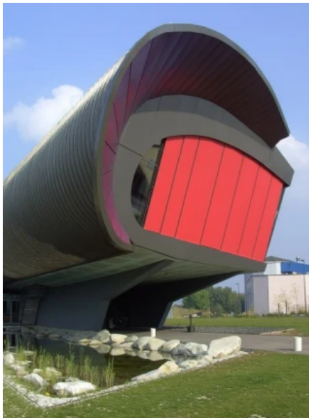
Brichta Gegenzuganlage, Verwaltung der Müllverbrennung Schwandorf
