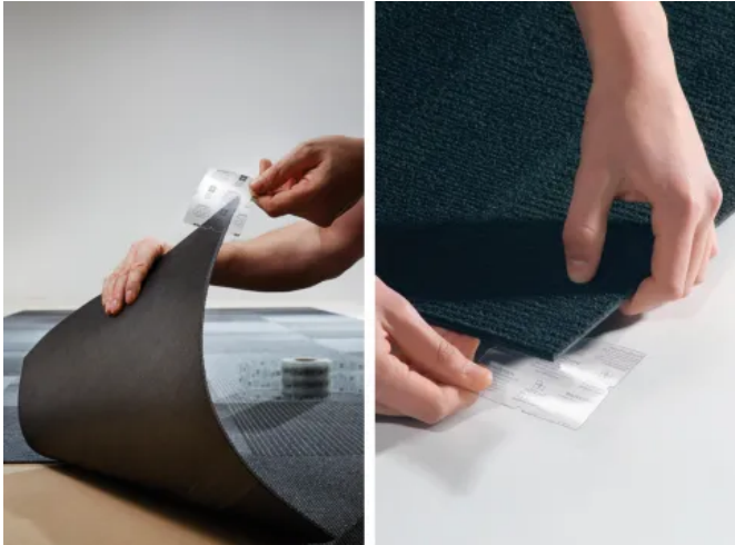
Verlegung mit TacTiles®
