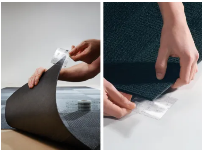
Verlegung mit TacTiles®
