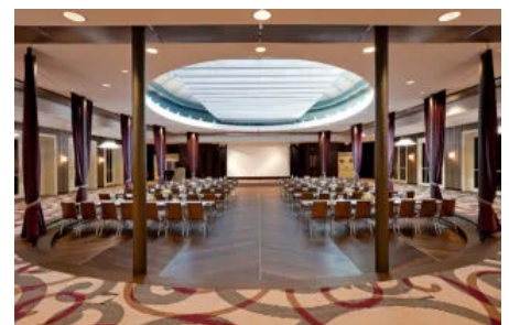
Raffanlage mit verdeckter Antriebstechnik, Steigenberger Hotel, Augsburg
