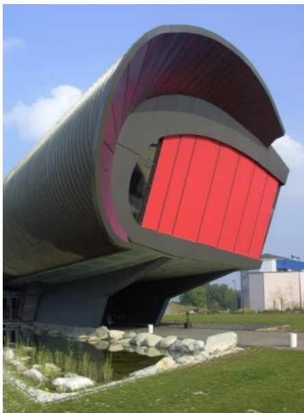
Brichta Gegenzuganlage, Verwaltung der Müllverbrennung Schwandorf
