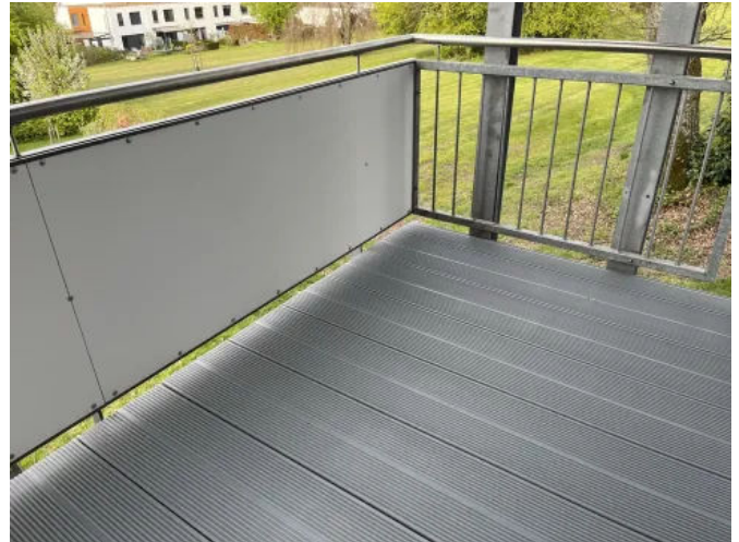
Die ebene Bodenfläche ohne sichtbare Verschraubungen wird durch die wasserableitenden Profile gleichmäßig entwässert.
