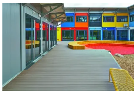
Character Massive Baumrindenbraun, Grundschule Halfengasse in Köln © Robert Sprang
