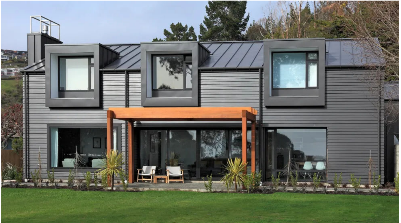
Accoya® – Fassadenbekleidungen aus acetylierter Radiata Pine, schwarz beschichtet
