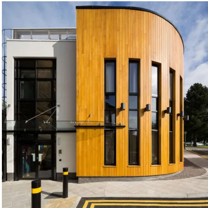
Accoya® – Fassadenbekleidungen aus acetylierter Radiata Pine
