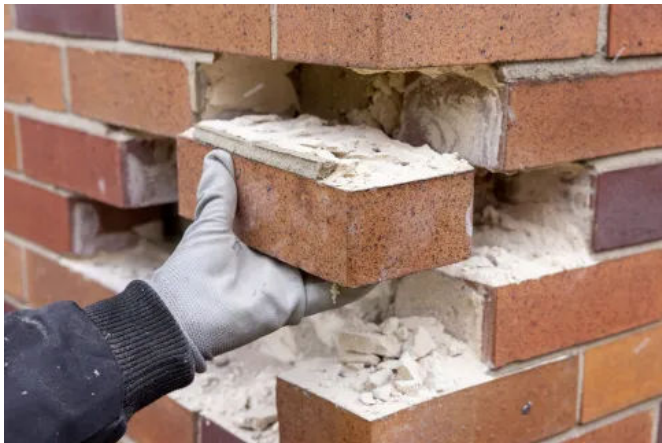
Terca ReviBrick® wird aus rückgebauten Bestandsziegeln gewonnen. (© copyright protected by hannokeppel.de)
