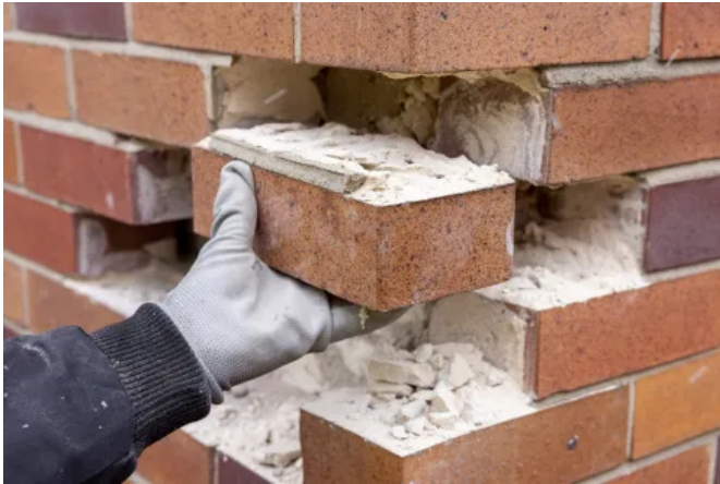
Für Terca ReviBrick® werden Bestandsziegel in einem standardisierten Verfahren rückgebaut, gereinigt, sortiert und auf Wiederverwendbarkeit geprüft.
