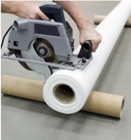
Die GIGA-Rollen können entsprechend der Raumhöhe individuell zugesägt werden.
