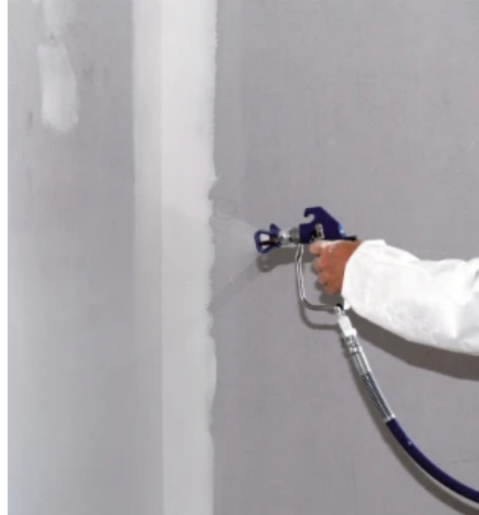
Der effiziente Kleisterauftrag erfolgt mit dem Airless-Gerät.
