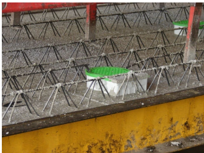
Elektroinstallation in Ortbeton
