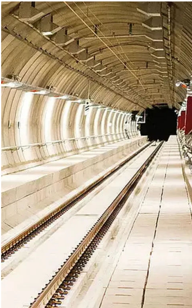
Eisenbahntunnel Liefkenshoek Belgien
