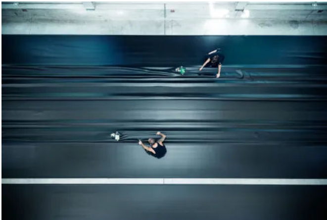
Abdichtung Nacktdach NovoProof mit der Contec.proof - EPDM Abdichtungsfolie
