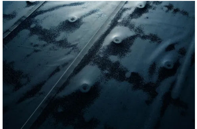
Die Abdichtung wird mit den mechanischen Befestigungen Contec.fix oder Contec.fix SFS isoweld® befestigt.
