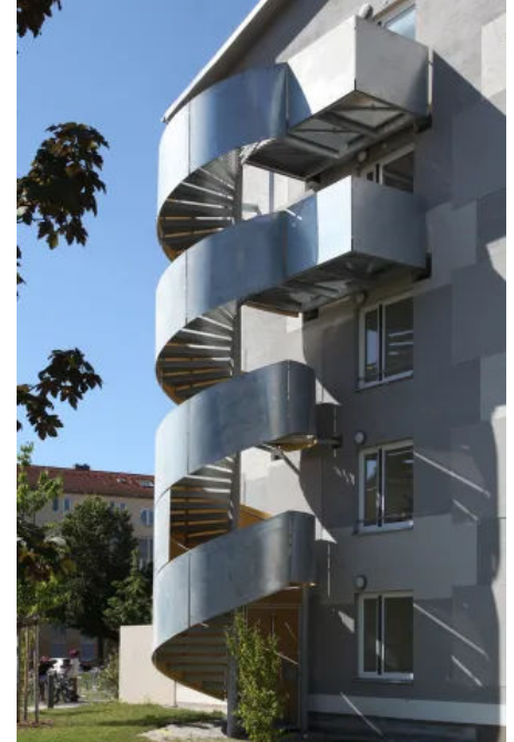
Objekt „Mehrfamilienhaus München“
