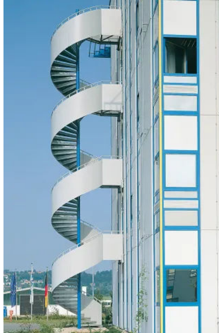
Objekt „Lagerhalle Saarbrücken“
