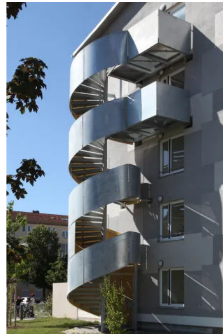
Objekt „Mehrfamilienhaus München“
