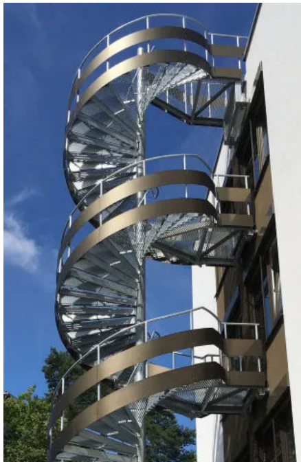
Objekt „Bürogebäude Nürnberg“
