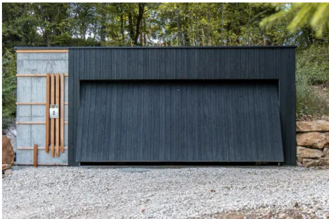
Referenzobjekt "SUYAKI | REGENSBURG GARAGE"
