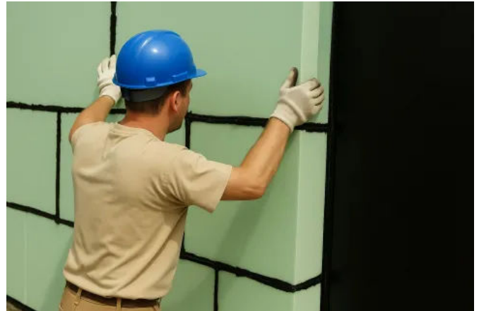
Ansetzen der Styrodur® -Platten und Verspachteln der Fugen gegen drückendes Wasser
