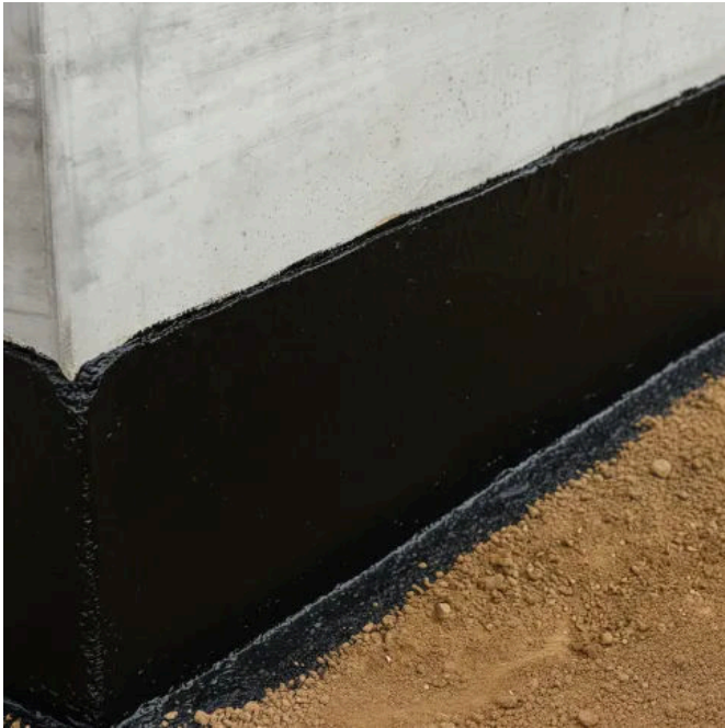
Abdichtung der Kellerwand gegen drückendes Wasser
