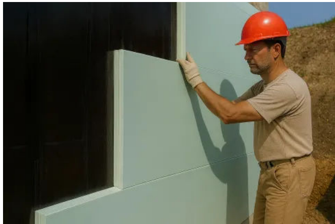
Dichtgestoßene Styrodur®-Platten sorgen für eine wärmebrückenfreie Perimeterdämmung
