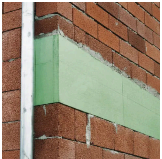
Wärmedämmung am Deckenrand mit Styrodur® 2800
