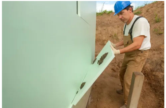
Punktweise Verklebung der zweiten Lage Styrodur®-Platten mit Stufenfalz und versetzten Fugen
