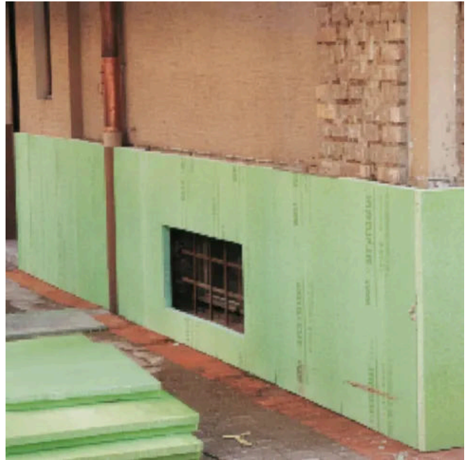
Nachträgliche Sockeldämmung
