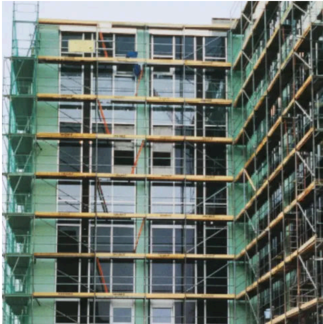
Wärmebrückendämmung mit Styrodur® 2800 C
