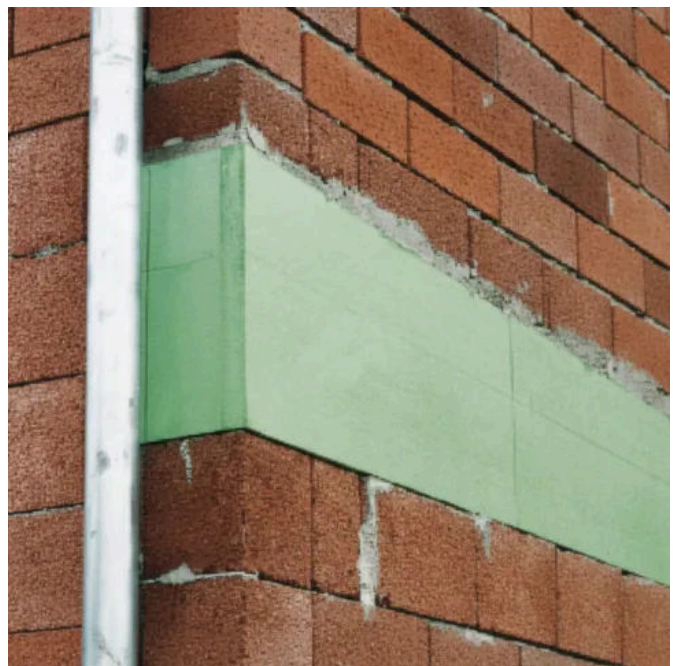
Wärmedämmung am Deckenrand mit Styrodur® 2800
