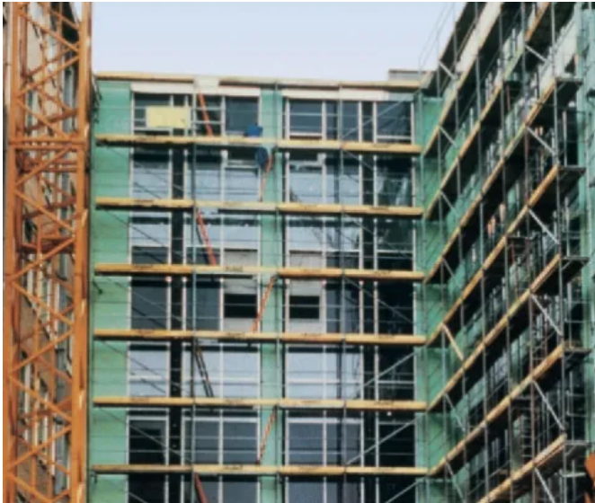
Wärmebrückendämmung mit Styrodur® 2800 C
