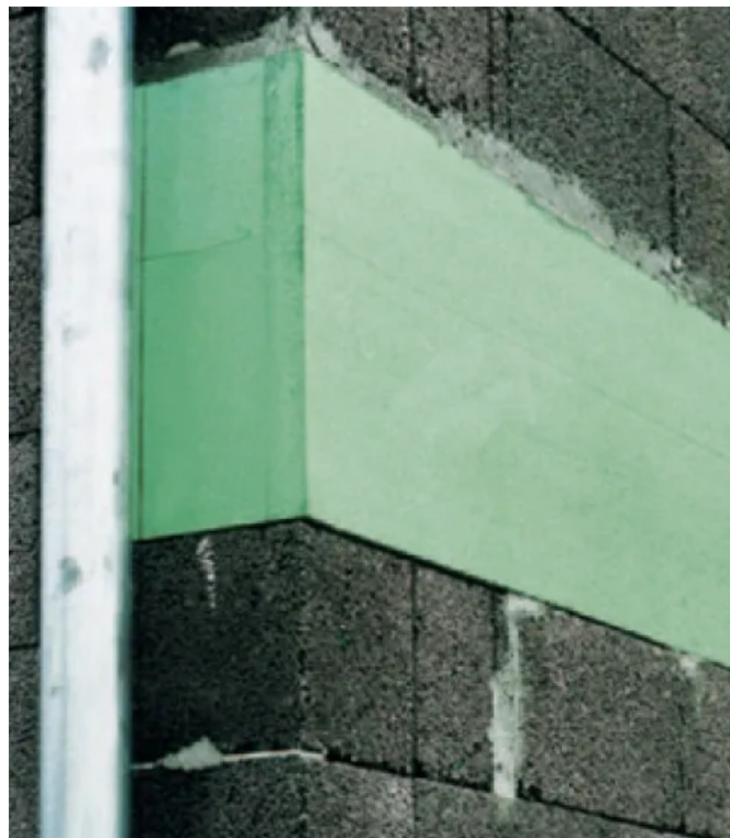
Wärmedämmung am Deckenrand mit Styrodur® 2800
