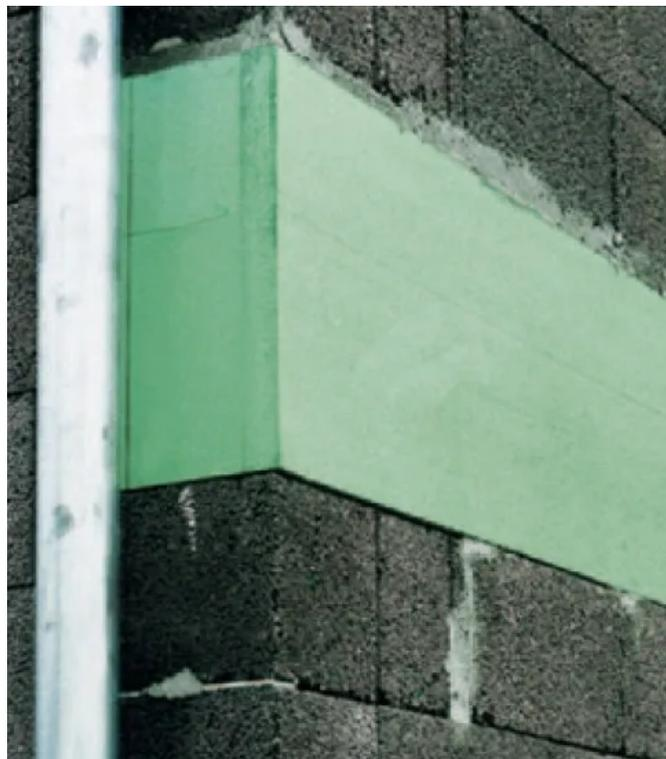
Wärmedämmung am Deckenrand mit Styrodur® 2800
