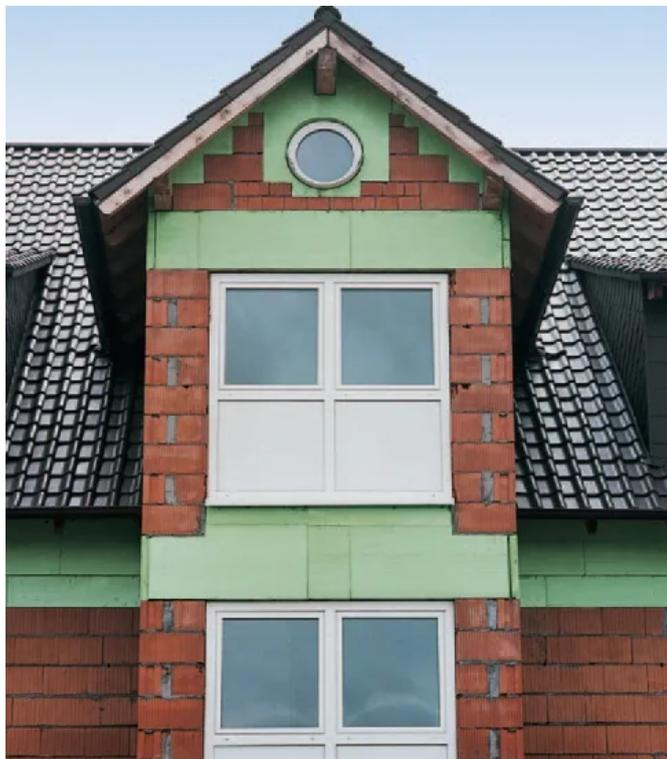
Wärmebrückendämmung von Betonbauteilen: Ortgang, Firstauflager, Ringanker, Fenstersturz, Deckenrand
