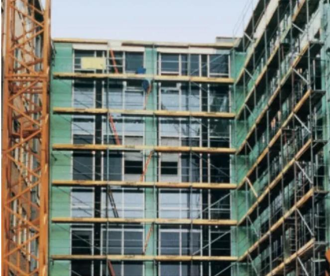
Wärmebrückendämmung mit Styrodur® 2800 C
