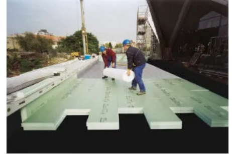
Verlegung von Styrodur C® oberhalb der Dachabdichtung.
