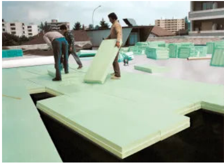
Verlegung von Styrodur® beim Duodach
