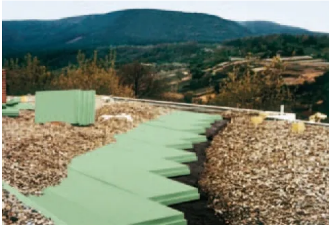
Saniertes UK-Dach als Plusdachkonstruktion
