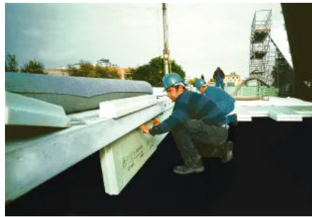
Attika-Dämmung mit Styrodur®
