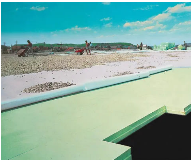
UK-Dach mit Trennlage und Kiesschüttung
