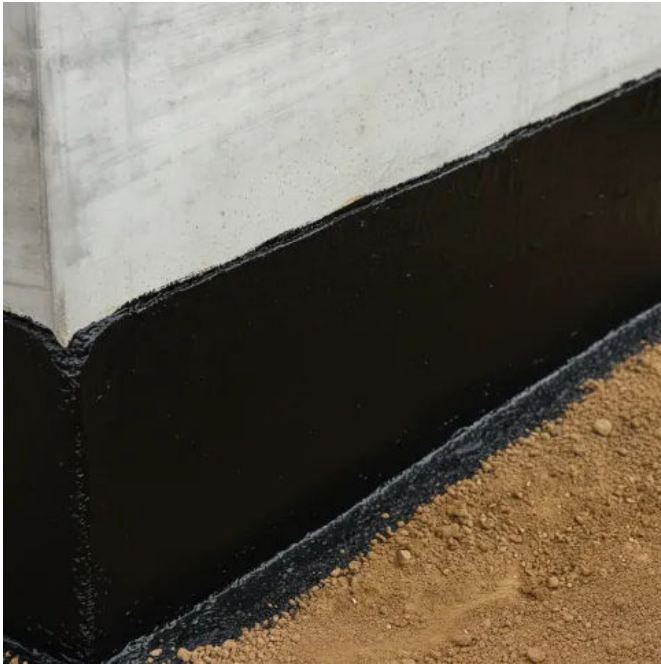
Abdichtung der Kellerwand gegen drückendes Wasser
