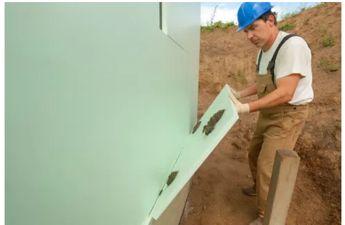
Punktweise Verklebung der zweiten Lage Styrodur®-Platten mit Stufenfalz und versetzten Fugen
