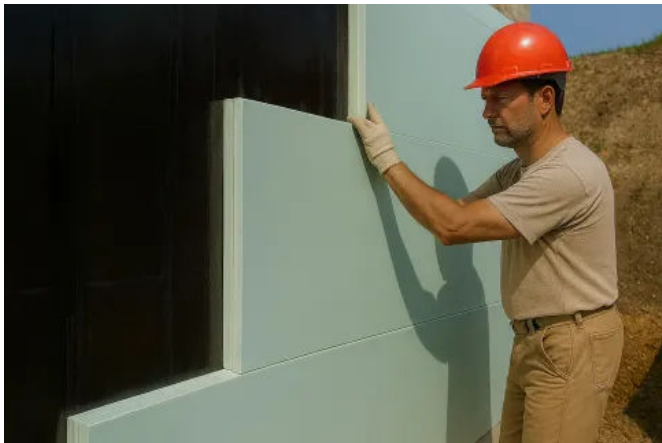
Dichtgestoßene Styrodur®-Platten sorgen für eine wärmebrückenfreie Perimeterdämmung
