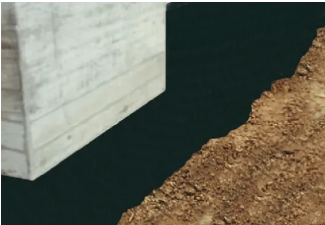
Abdichtung der Kellerwand gegen drückendes Wasser
