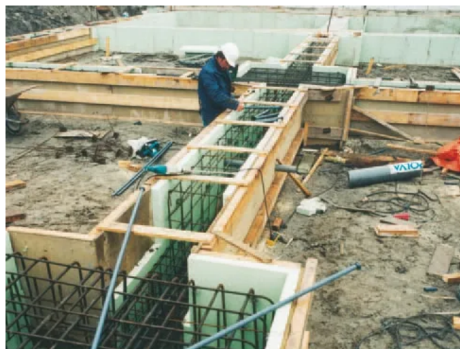
Schalung mit Styrodur®
