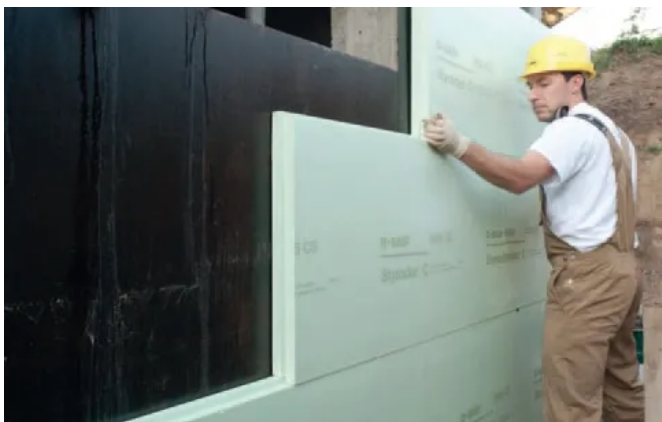
Dichtgestoßene Styrodur®-Platten sorgen für eine wärmebrückenfreie Perimeterdämmung
