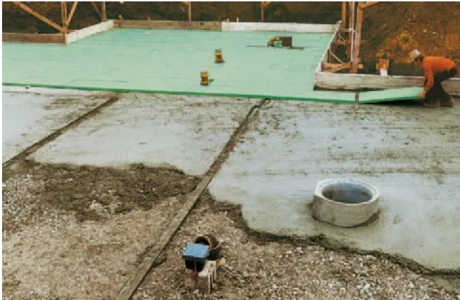
Sauberkeitsschicht aus Magerbeton zur Verlegung der Bodendämmung
