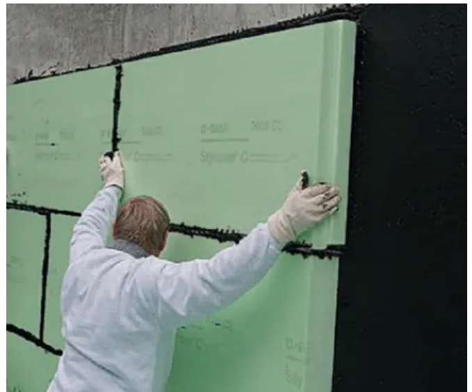
Ansetzen der Styrodur® -Platten und Verspachteln der Fugen gegen drückendes Wasser
