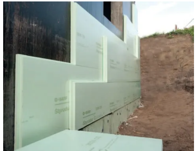
Sicherung einer zweilagigen Perimeterdämmung aus Styrodur®-Platten bis zum Verfüllen der Baugrube.
