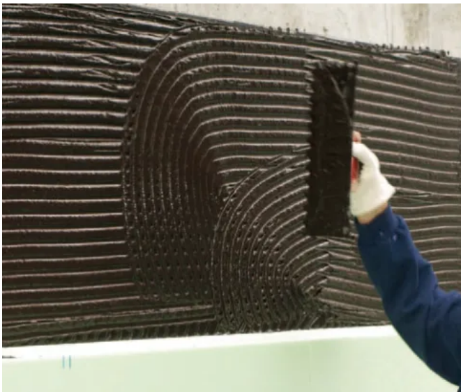
Vollflächiges Verkleben der Dämmplatten bei drückendem Wasser
