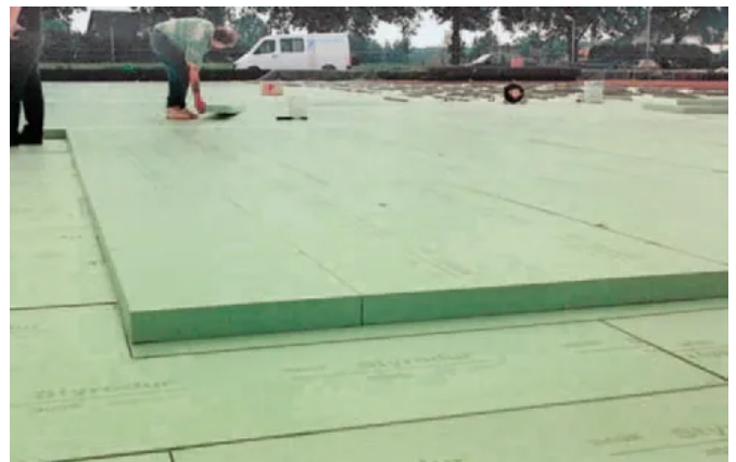
Mehrlagige Verlegung von Styrodur®-Platten unter Bodenplatte nach DIBt Bauartgenehmigung
