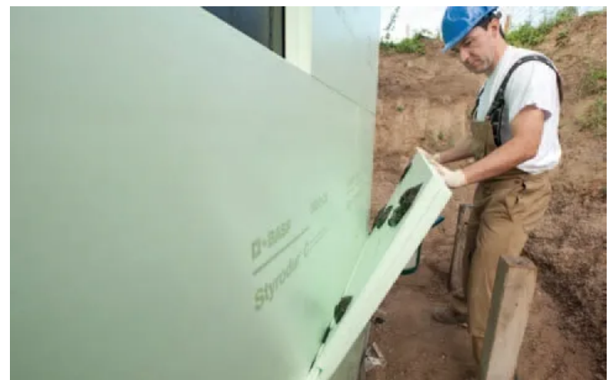
Punktweise Verklebung der zweiten Lage Styrodur®-Platten mit Stufenfalz und versetzten Fugen
