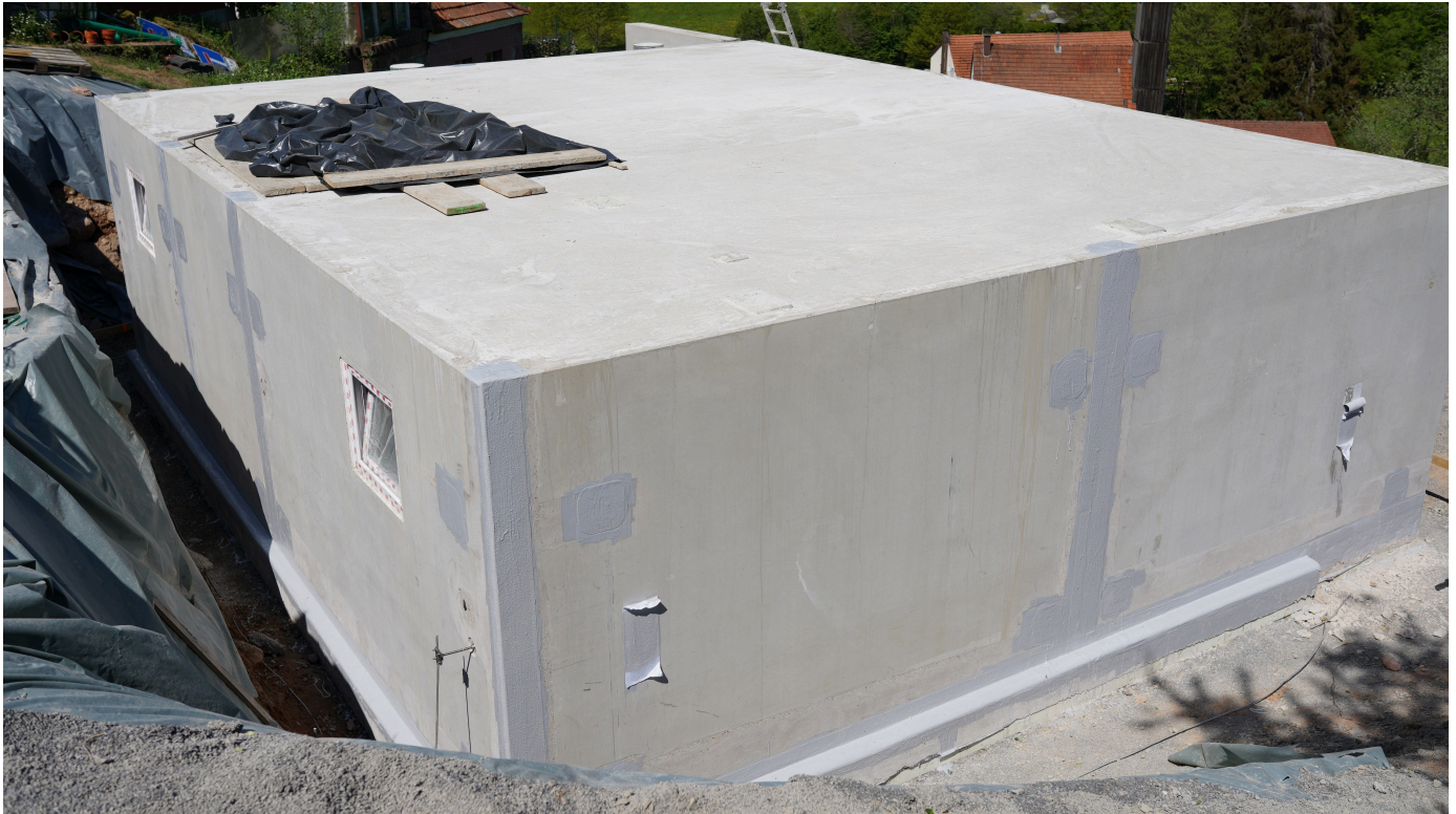
Abdichtungssystem für Arbeits- und Sollrissfugen bei Bauteilen aus wasserundurchlässigem Beton (WU-Beton) zum Schutz der Bausubstanz.
