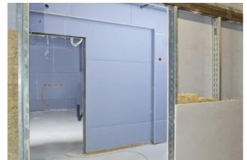
Für Schutz vor Beschädigungen und die perfekte Oberfläche sorgt eine Decklage Knauf Diamant.
