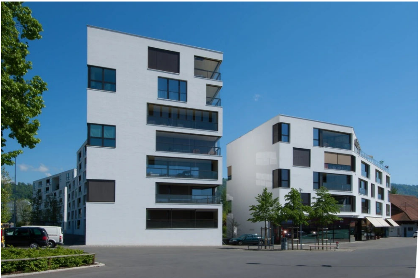
Wohnüberbauung Schützengel, Zug, CH, Foto: Günter Laznia, Bregenz, AT
