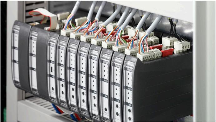
Steuerzentralen steuern alle RWA Komponenten für einen sicheren Rauch- und Wärmeabzug im Brandfall. Die Notstromzentralen sind die Steuereinheit aller mit RWA Antrieben oder Türschließern ausgerüsteten Zu- und Abluftöffnungen. Intelligente Fassaden analysieren selbständig alle Umweltdaten.
