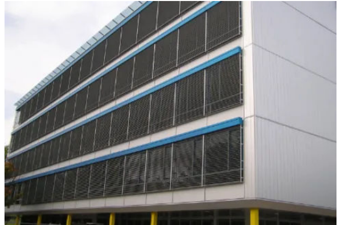
Schule Roche Nyon
