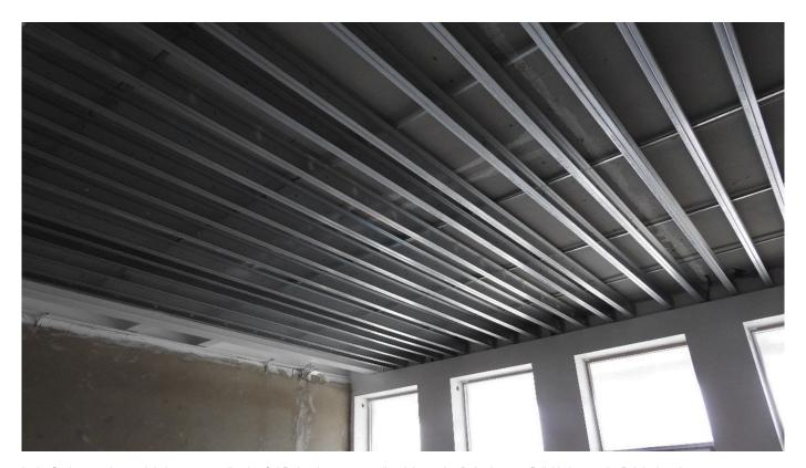
In der Sanierung, aber auch bei neu zu erstellenden Gebäuden, ist es notwendig, sich von den Befestigungsmöglichkeiten an der Rohdecke oder von bestehenden Dach- oder Deckenkonstruktionen zu lösen. Der Protektor Weitspannträger Edifico ist die Grundlage für Decken mit großen Spannweiten und offenen Raumstrukturen.
