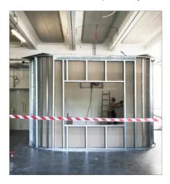
Nicht nur neue Räume innerhalb von bestehenden Gebäuden (Raum-in-Raum-Systeme) sind mit dem Edificio System zu realisieren. Die leichte Bauweise ist auch erste Wahl bei Aufstockungen, wo auf Grund begrenzter statischer Verhältnisse nur geringe zusätzliche Lasten möglich sind. Mit Edificio sind natürlich auch Gebäudeerweiterungen als Anbauten zu verwirklichen.
