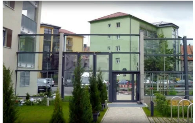
Vertikale Tragstruktur – Schallschutzwand Fürth
