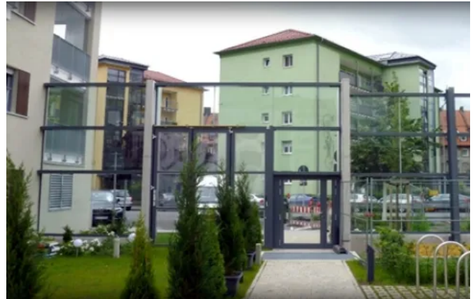
Vertikale Tragstruktur – Schallschutzwand Fürth
