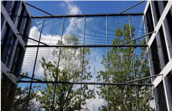
Horizontale Tragstruktur HdH in Bonn
