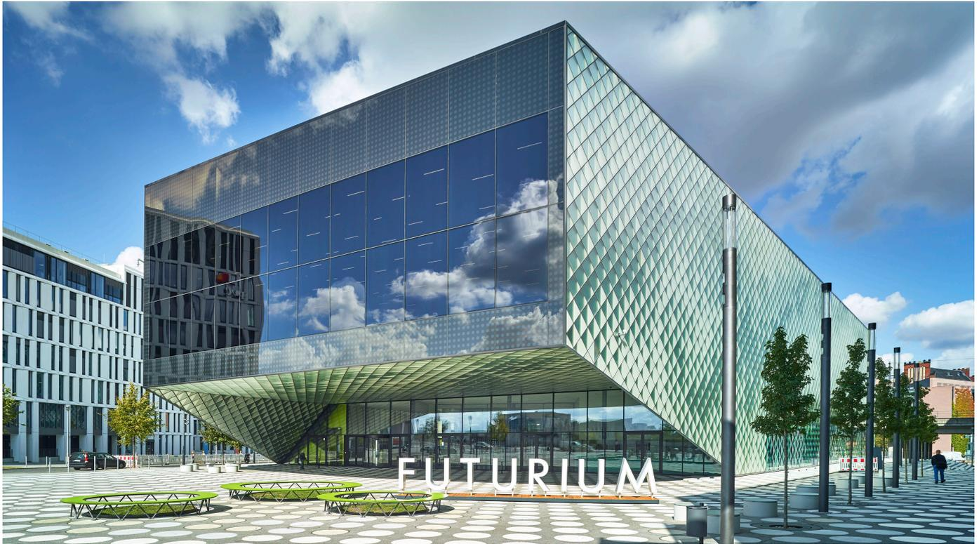
Mit dem VISS System bietet Schüco Stahlssysteme Jansen eine hochwärmegedämmte Fassadenkonstruktion für jede Anwendung, sowohl bei Neubau als auch beim Bauen im Bestand. Entsprechend den statischen Erfordernissen, der Scheibengrößen oder der Füllelementdicken werden die technisch und wirtschaftlich optimalen Komponenten aus dem Systembaukasten ausgewählt.
