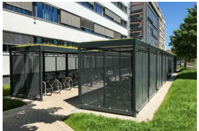
Fahrradüberdachung Köln mit Dachbegrünung und Anlehnbügel
