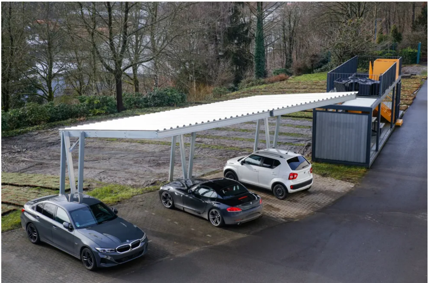
Referenzbeispiel einer EcoCover Carportanlage
