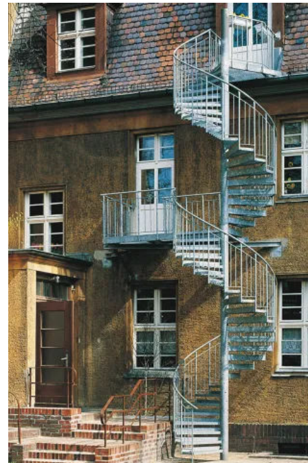
Objekt „Kindergarten Berlin“
