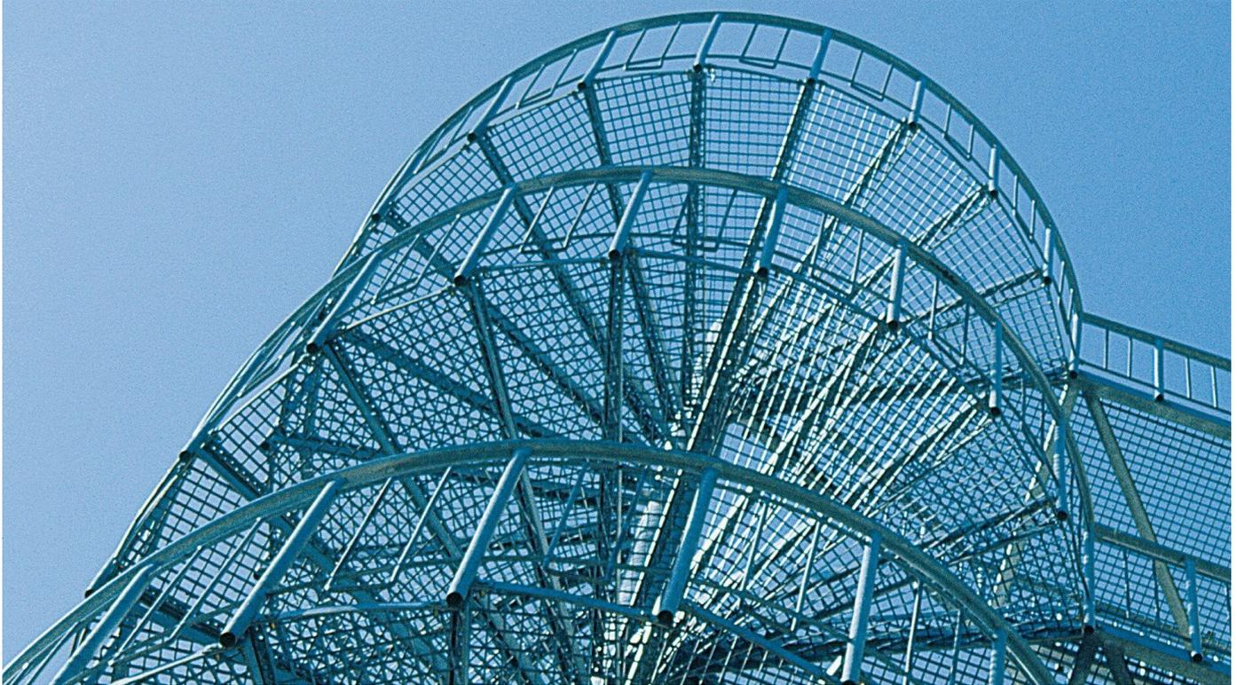
Systemspindeltreppen HBS mit tragender Mittelsäule aus Stahlrohr und angeschraubten Trittkonstruktionen.
