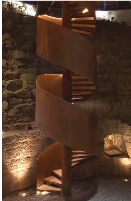
Objekt „Burgruine Hardenburg“
