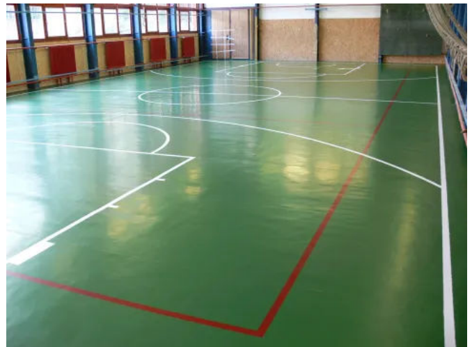
Sporthalle nachher: renovierter Boden
