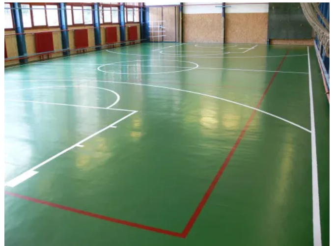
Sporthalle nachher: renovierter Boden
