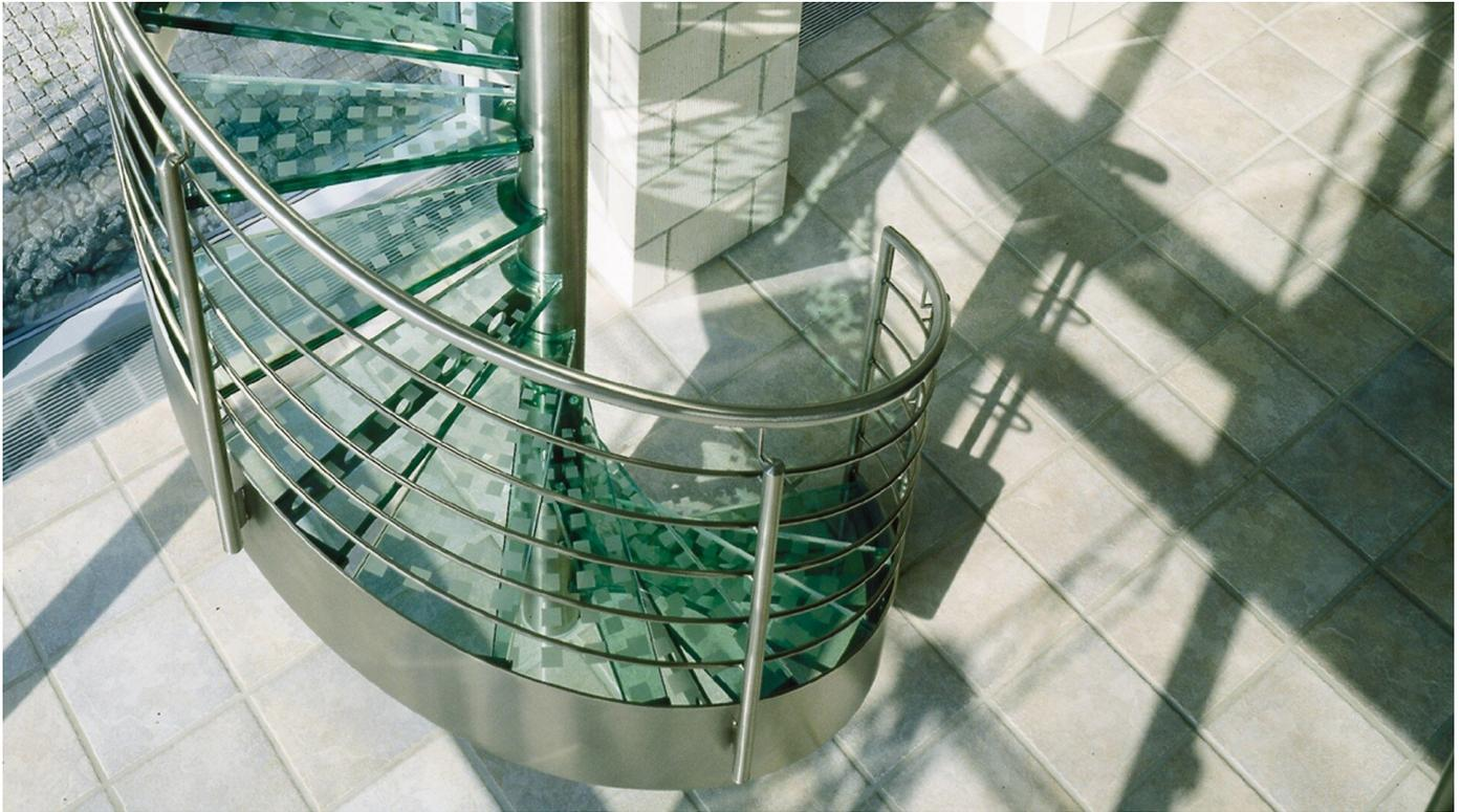
Spindeltreppen mit tragender Mittelsäule aus Stahlrohr und angeschweißten Trittkonstruktionen.
