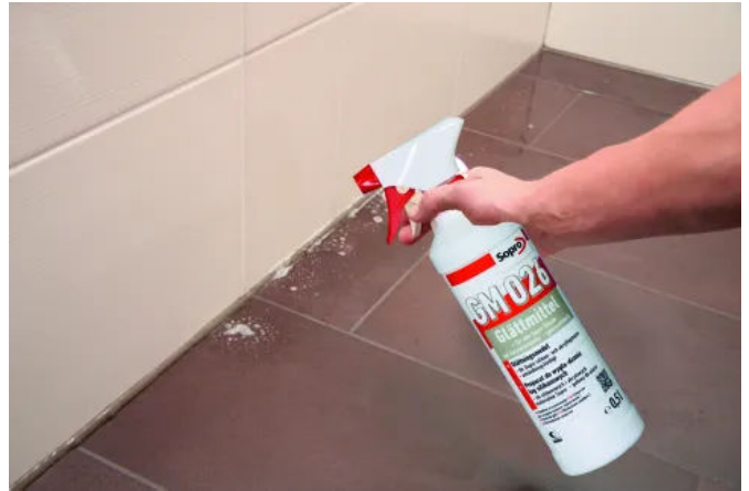
Die Fuge mit Sopro Glättmittel einsprühen und vor Einsetzen einer Hautbildung mit einem Silikonglätter sauber abziehen und glätten.
