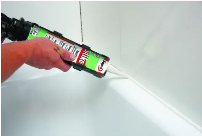
Sopro SanitärSilikon einbringen.
