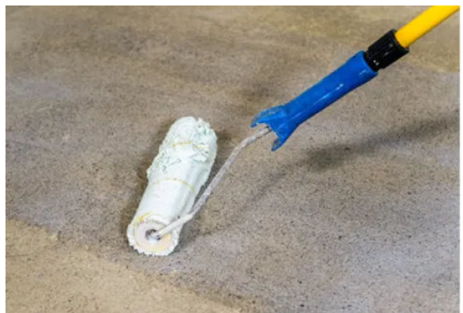
Saugfähige Bodenflächen werden mit Sopro Grundierung vorbehandelt.
