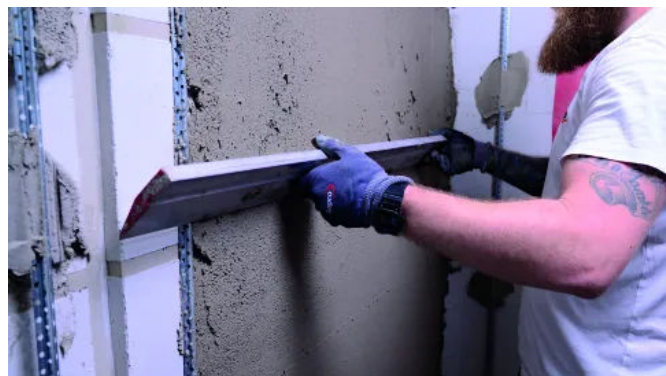
Für Schichtdicken von 3–60 mm und schnelle Belegereife (ca. 2 Stunden) ist der Sopro RAM 3® Renovier- & Ausgleichsmörtel gut geeignet.
