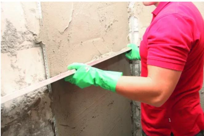
Für Schichtdicken von 3–60 mm und schnelle Belegereife (ca. 2 Stunden) ist der Sopro RAM 3<sup>®</sup> Renovier- & Ausgleichsmörtel gut geeignet.
