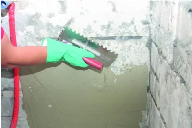
Mit der glatten Seite der Kelle zunächst unter Druck eine Kontaktschicht aufziehen ...
