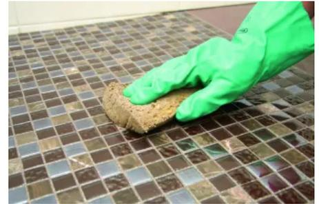
Je nach Beanspruchung kommen zementäre oder Epoxidharz-Fugenmörtel zum Einsatz. Epoxidharz eignet sich besonders für stark belastete Bereiche wie Industrie, Gewerbe, Großküchen oder Schwimmbäder, da es äußerst widerstandsfähig gegen mechanische und chemische Einflüsse ist.
