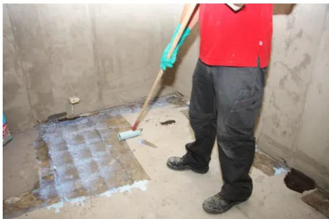
Saugfähige Bodenflächen (z. B. Zementestriche) werden mit Sopro Grundierung vorbehandelt.
