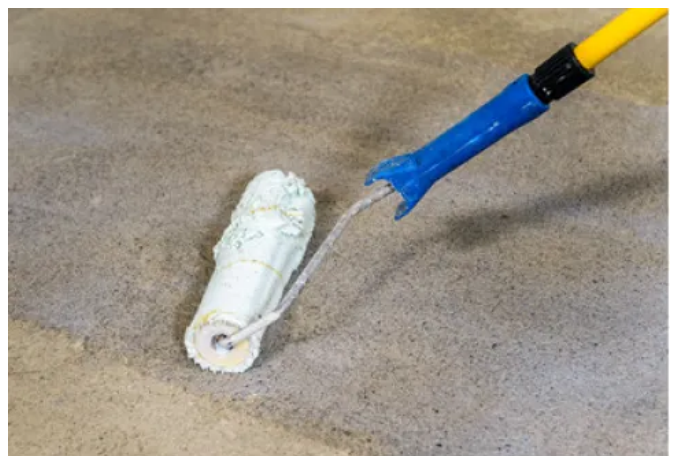
Saugfähige Bodenflächen werden mit Sopro Grundierung vorbehandelt.
