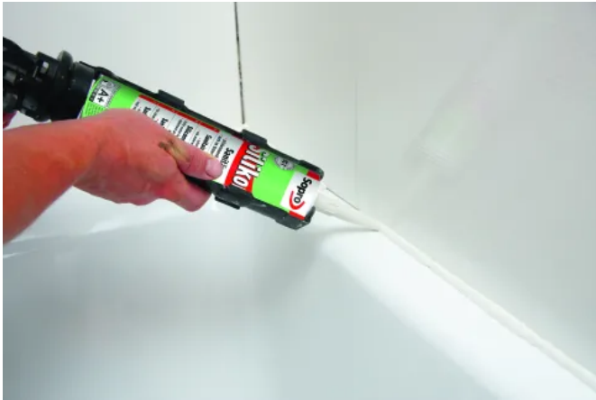
Sopro SanitärSilikon einbringen.
