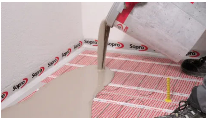
Verlegung elektrischer Heizsysteme mit Sopro Fließspachtelmassen
