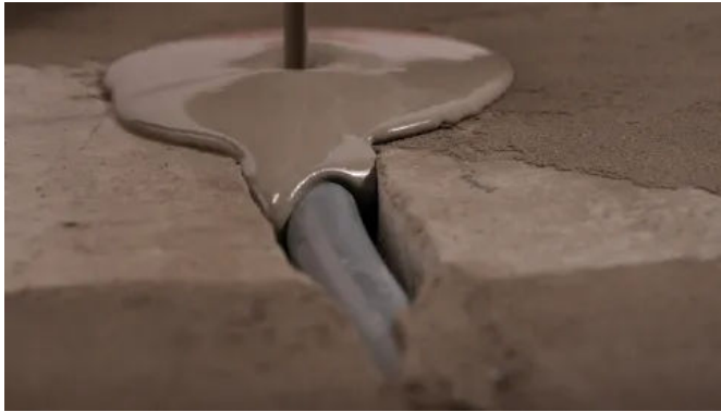
Fußbodenheizungs-Frässysteme mit Sopro Fließspachtelmassen
