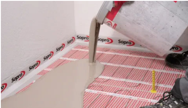
Verlegung elektrischer Heizsysteme mit Sopro Fließspachtelmassen
