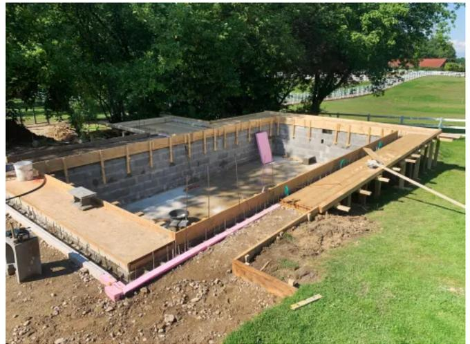
Die Poolwände aus Schalungssteinen werden mit einer Bodenplatte aus Ortbeton kombiniert und mit dieser konstruktiv verbunden.
