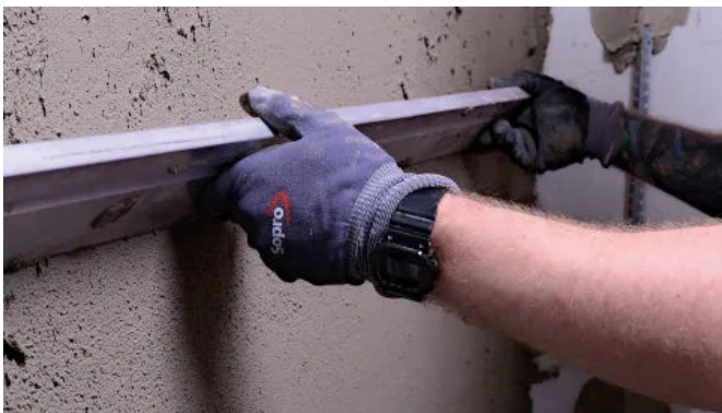
Renovierung: Wiederherstellung oder Erneuerung.
