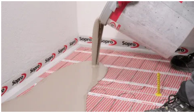
Verlegung elektrischer Heizsysteme mit Sopro Fließspachtelmassen
