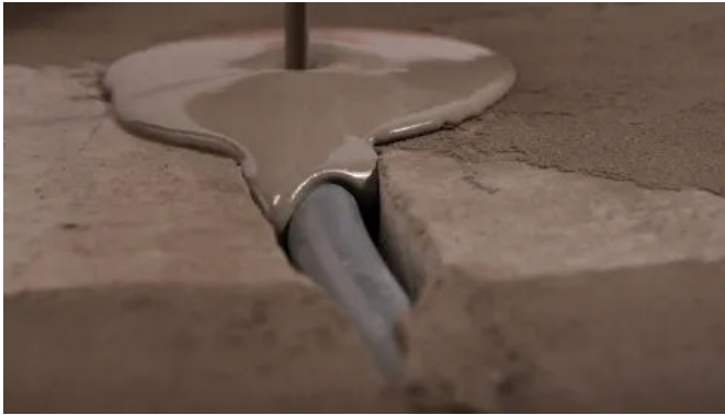
Fußbodenheizungs-Frässysteme mit Sopro Fließspachtelmassen
