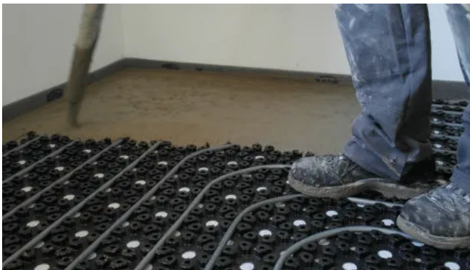
Dünnschichtige Lösungen (z. B. Kermix-net C15 Dünnschichtsystem)
