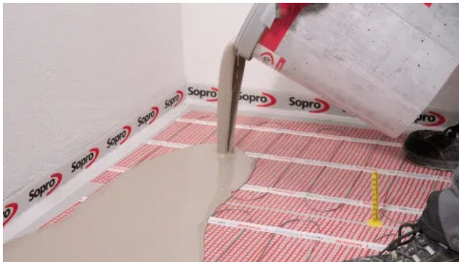
Verlegung elektrischer Heizsysteme mit Sopro Fließspachtelmassen
