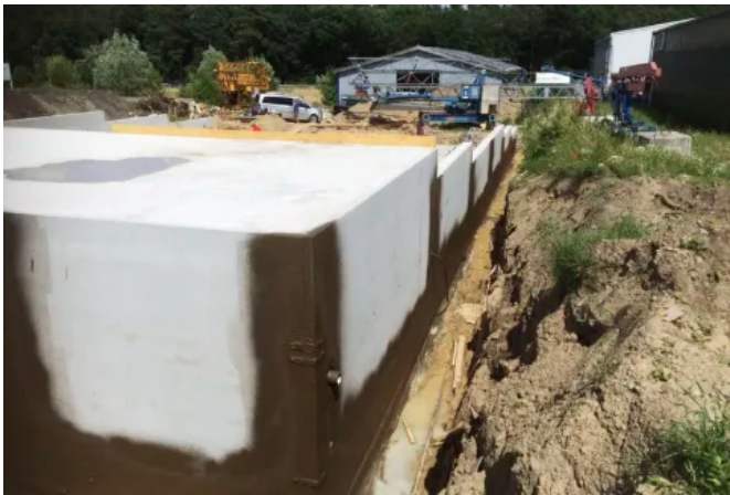
Abdichtungsanschluss an WU-Beton Bodenplatten
