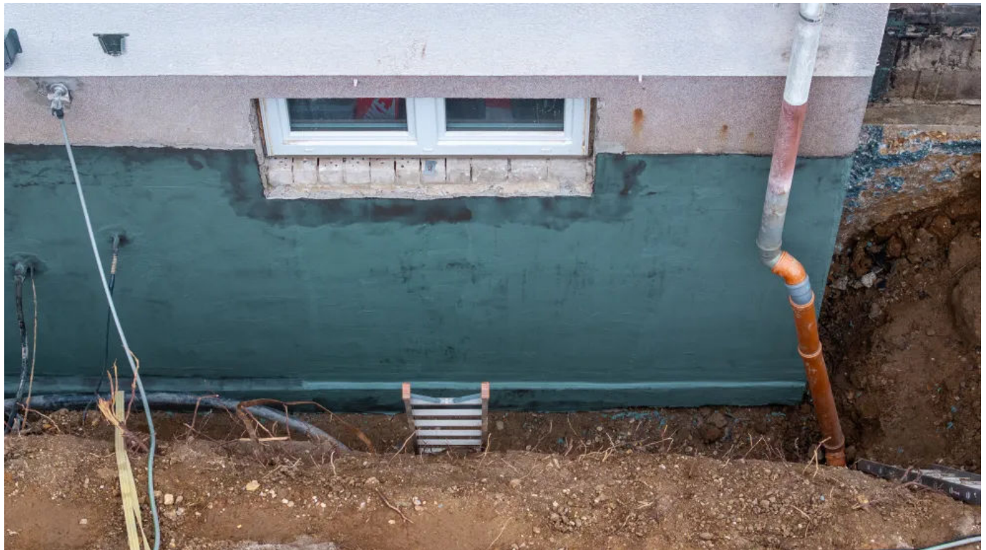
Überarbeitete Altabdichtung mit FPD (© Christoph Mertens)
