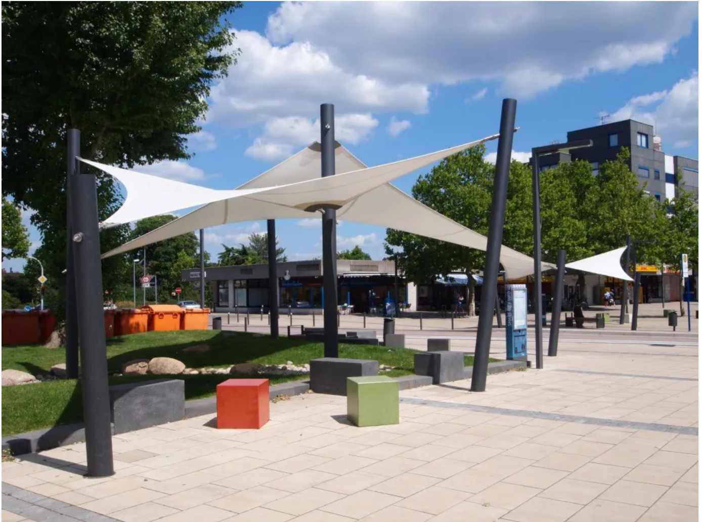
Dreidimensionales Sonnensegel, in der Form eines Hypars
