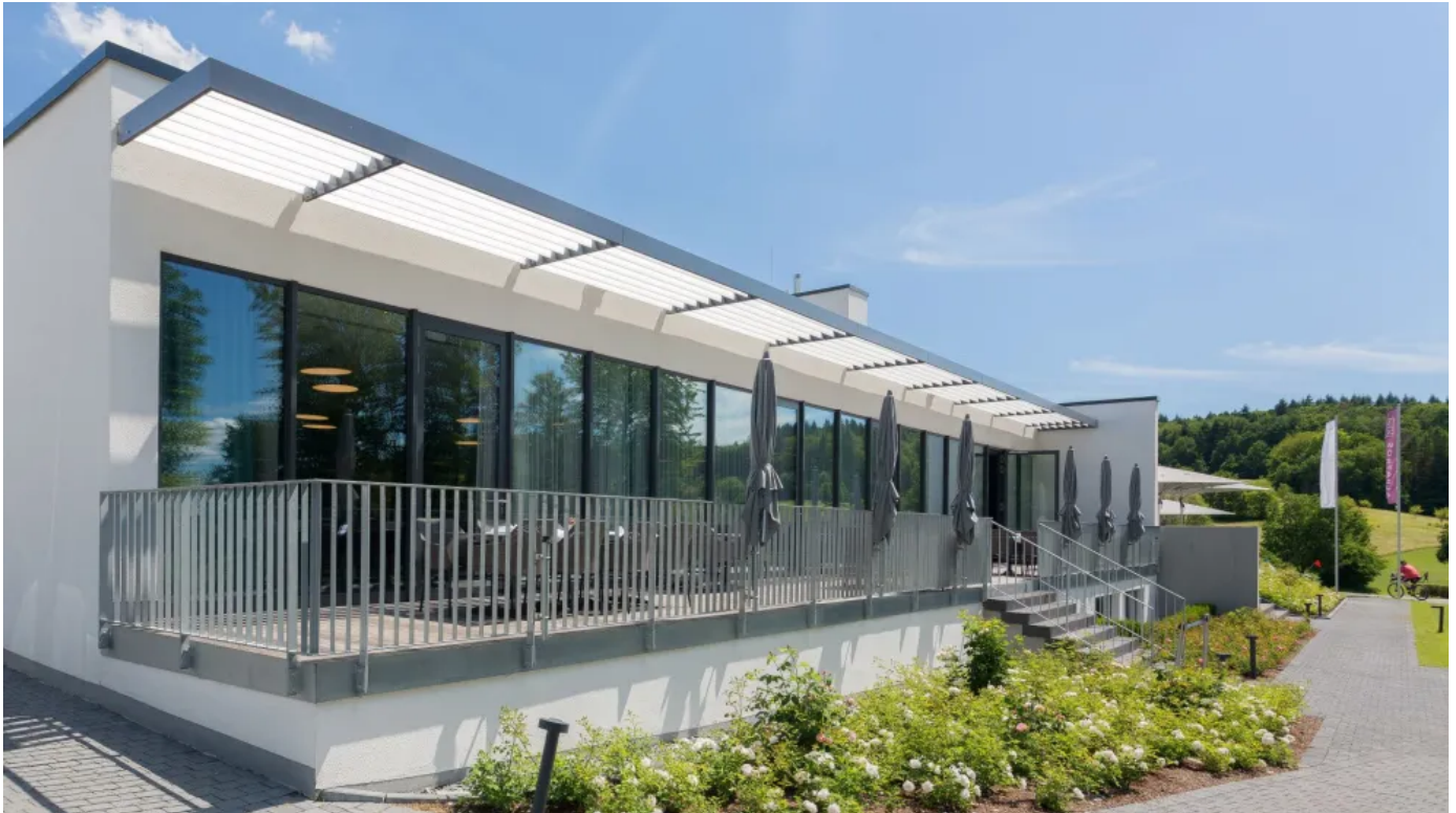
Auskragende Großlamellen-Sonnenschutzsysteme verhindern eine direkte Sonneneinstrahlung
