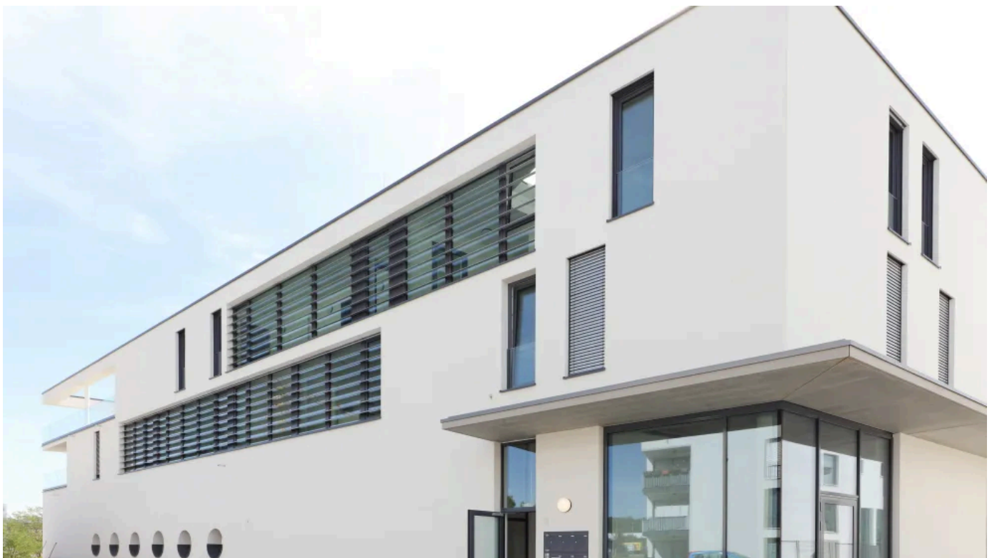
Horizontale Lösungen schützen am besten vor direkter Lichteinstrahlung.
