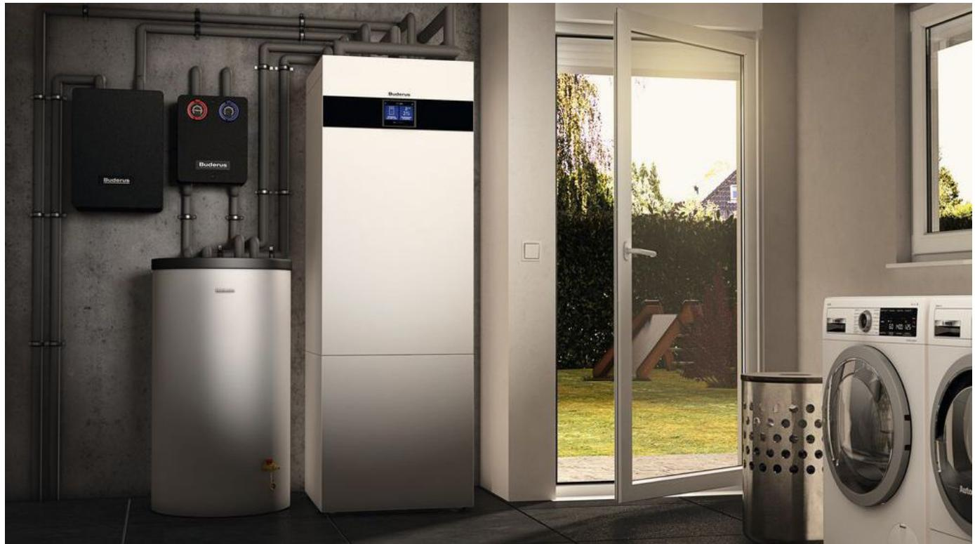
Eine Sole-Wasser-Wärmepumpe stellt mithilfe von Geothermie (Erdwärme) Wärme für Heiz- und Warmwassersysteme bereit. Die thermische Energie wird dabei entweder bodennah über Flachkollektoren oder aus der Tiefe über Erdsonden gewonnen. Eine in den Leitungen zirkulierende Sole-Flüssigkeit nimmt die Wärmeenergie auf und gibt sie an ein Kältemittel ab, welches dabei aufgrund des niedrigen Siedepunkts verdampft.
