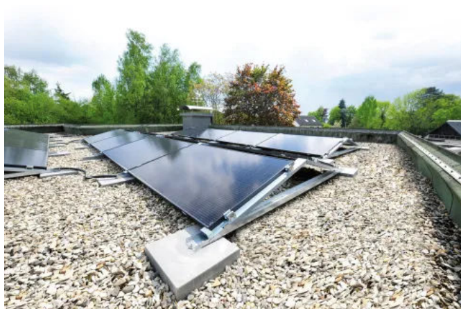
Die Unterkonstruktion wurde auf Grundlage des erstellten Ballastierungsplans mit verschraubbaren Ballastierungssteinen beschwert.
