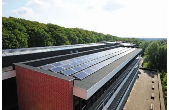
Die Unterkonstruktionen ermöglichen dank ihrer Süd-Ausrichtung von 15 Grad für besonders hohe Erträge während der Mittagsstunden.
