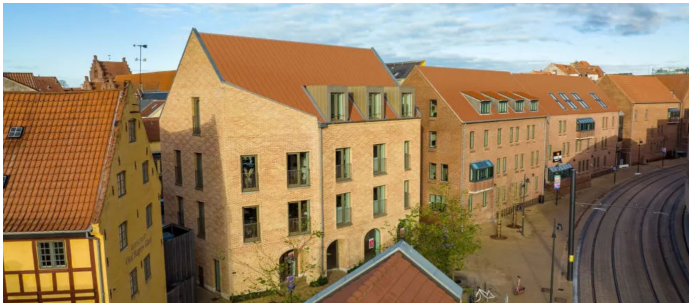
Bauvorhaben Odense ©Ennogie
