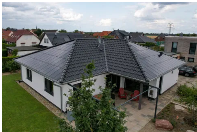
Bauvorhaben FSC ©Ennogie
