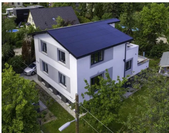
Bauvorhaben Riedl Berlin ©Ennogie
