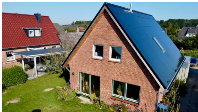
Bauvorhaben Keller ©Ennogie
