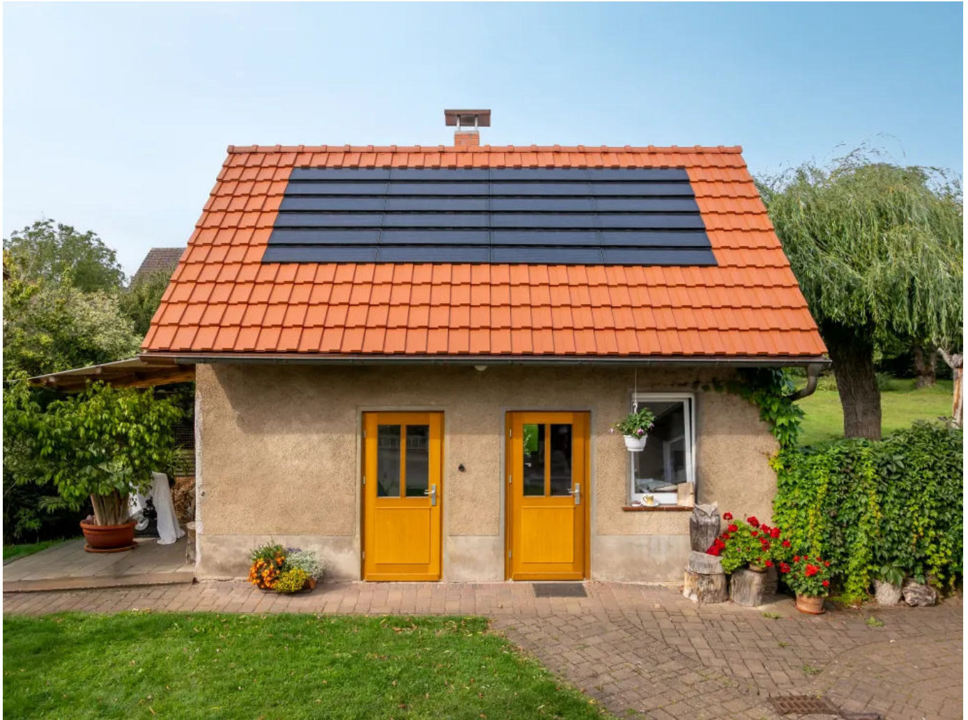
Dacheindeckung mit J160-PV Indach-Modulen, edelschwarz (© Susanne Buchholz)
