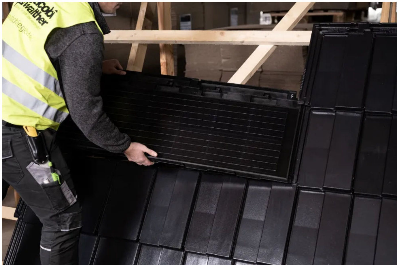
Verlegung der J160-PV Indach-Module
