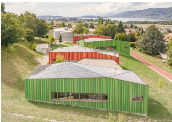
Kindergarten - Ipsach Schweiz | ©Andreas Buschmann | Integration des Ziegels in jede Dachform.
